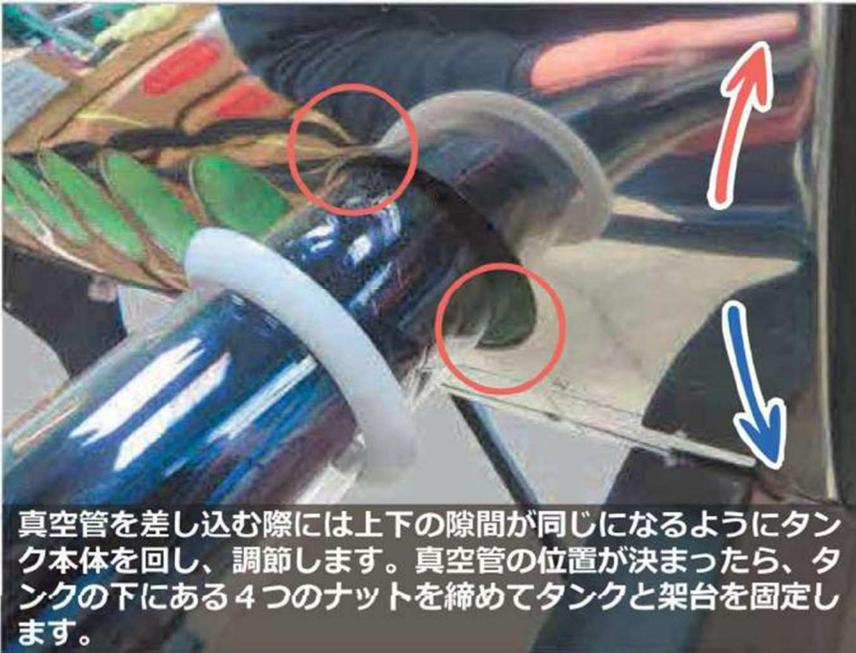
真空管を差し込む際には上下の隙間が同じになるようにタンク本体を回し、調節します。真空管の位置が決まったら、タンクの下にある4つのナットを締めてタンクと架台を固定します。
